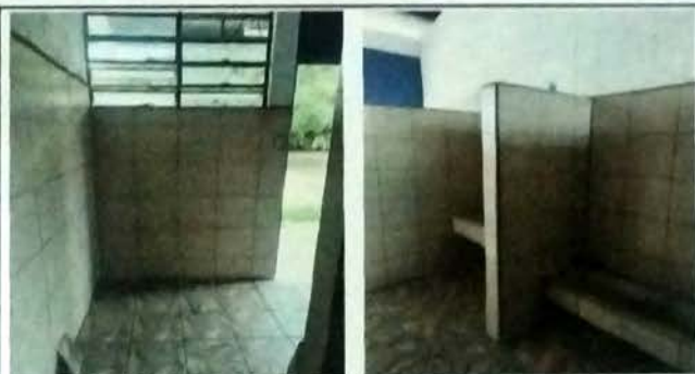
Foto 9: MODULO SERVICIO SANITARIO. Instalacion de piso ceramico y aplicacion de azulejo en muros, vista de urinario
