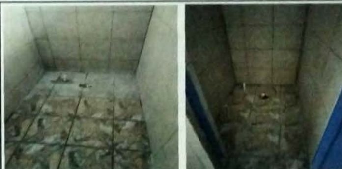
Foto 10: MODULO SERVICIO SANITARIO. Instalacion de piso ceramico y aplicacion de azulejo en muros.
