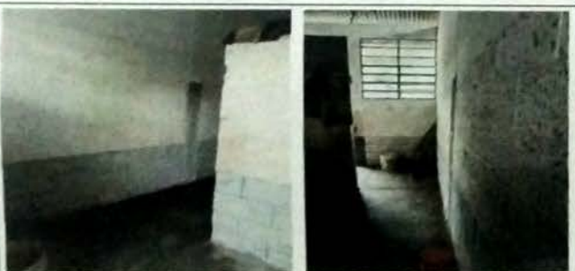
Foto 5: MODULO DE SERVICIO SANITARIO, Fase de picado de superficie en paredes.
