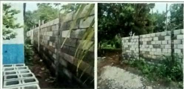
Foto 3: TRABAJOS EXTERIORES, Sanjeo para muro perimetral Vista norte sur y sur norte. Fase de levantado de block con columnas.
